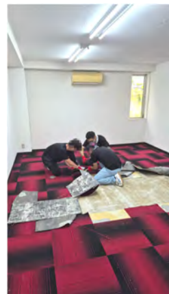
内装工事中の新しい事業所の古いじゅうたんを自分たちではがしています。
