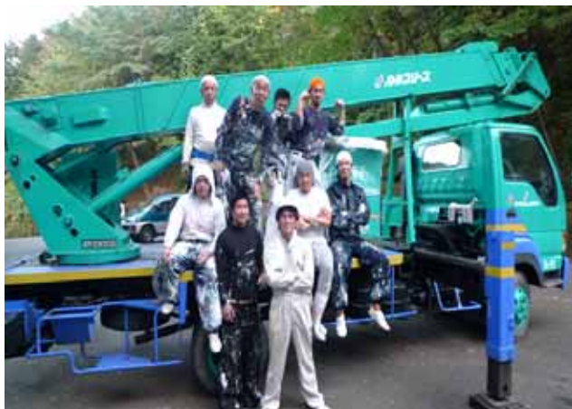
クレーン車を借りてきて建物の上までペンキの塗り替えをしました。
