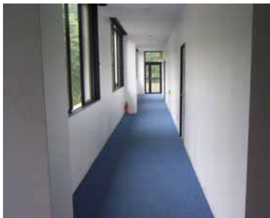
4階の廊下。雨漏りで天井が抜け落ちていたのですが新築のようになりました。
